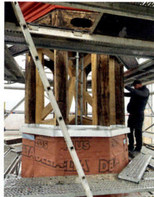
Die neue Aussteifung in der „Laterne“ über dem Turmhelm
