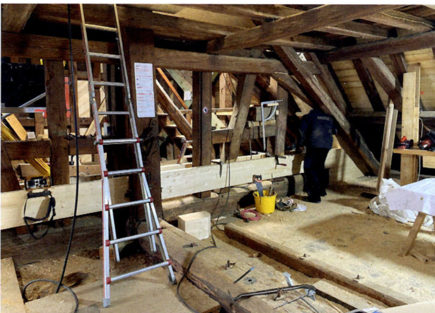
Der „Haupttakt“ der ganzen Sanierung: Der neue Binder zur Aussteifung zwischen Turm und Kirchenschiff wird eingebaut
