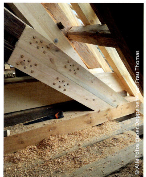
Der „Haupttakt“ der ganzen Sanierung: Der neue Binder zur Aussteifung zwischen Turm und Kirchenschiff wird eingebaut
