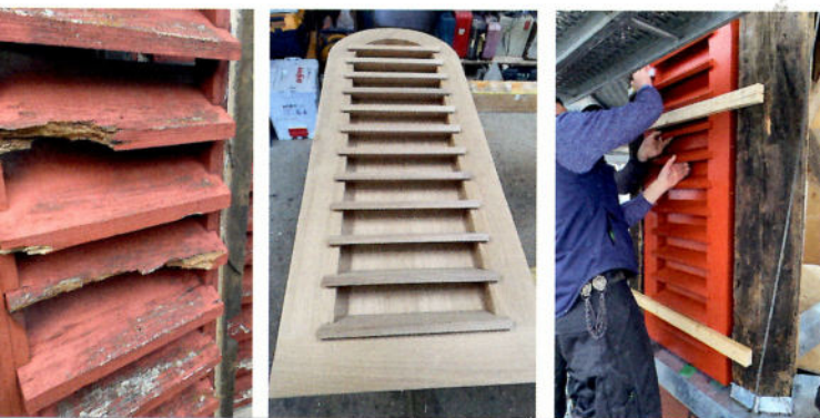
Die völlig maroden Schallluken wurden in der Zimmererwerkstatt neu gebaut und wieder eingebaut.
