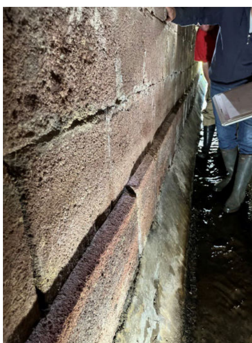
6 Wand-Fußanschluss
