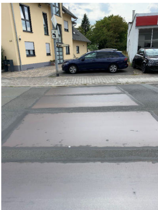
3 Oberseite der Unterführung in Richtung NO
